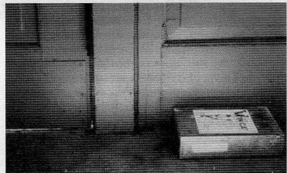
Figura 15-K. Las trampas de captura múltiple que se colocan directamente dentro de las puertas exteriores que no cuentan con un dispositivo de protección contra roedores. Atraparán a los ratones al entrar por debajo de la puerta.
