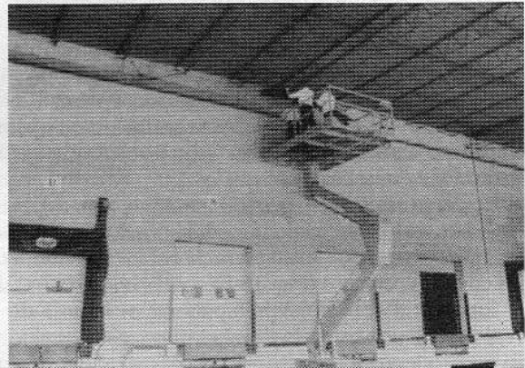
Figura 16-H. Colocación de una red de plástico para excluir aves del área de carga y descarga de una bodega. Se puede rentar alguna plataforma hidráulica como un equipo valioso para el trabajo con aves y otro tipo de fauna urbana.
